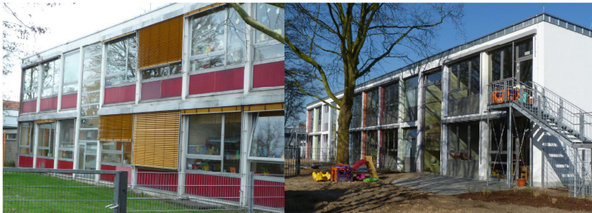
Abbildung 26: KiTa Heesstraße vor und nach der Sanierung
