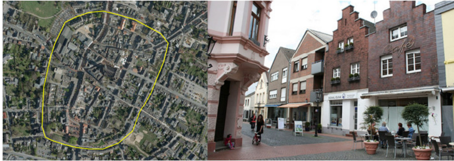
Abbildung 31: Quartier Historischer Stadtkern Dülken
