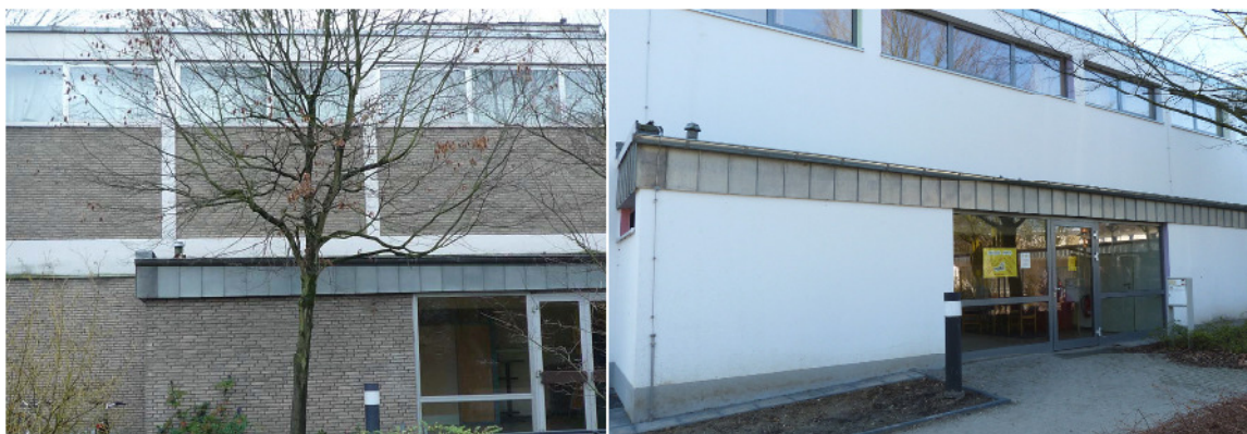
Abbildung 27: KiTa Heesstraße - Eingangsbereich vor und nach der Sanierung
