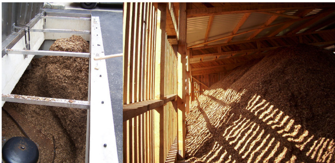
Abbildung 22: Holz hackschnitzelsilo am technischen Rathaus und das zentrale Hackschnitzzellager
